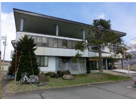
常盤地区活性化センター 3.0km 車で5分
