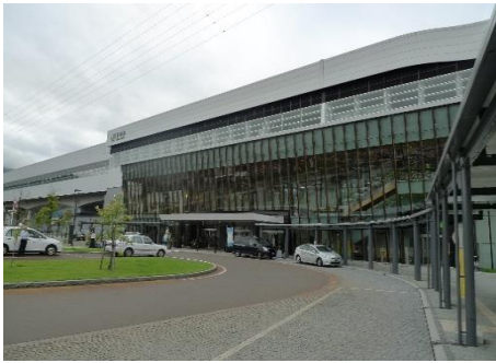
JR飯山駅(北陸新幹線停車駅) 0.8km 車で3分
