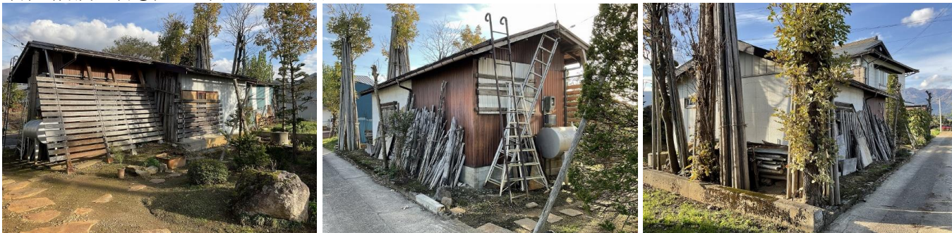
車庫(付属建物②) ※雪下ろし式屋根
