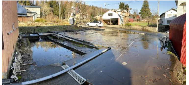
消雪用の水利施設 (敷地の消雪、屋根落雪の消雪用)
