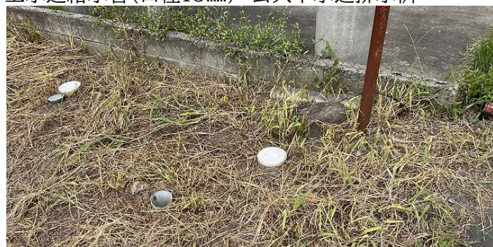
上水道給水管(口径13mm) 公共下水道排水柵
