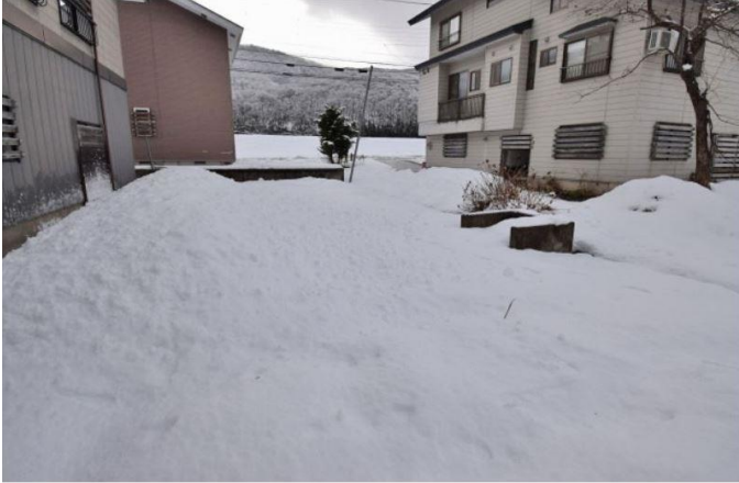
屋根からの落雪状況
