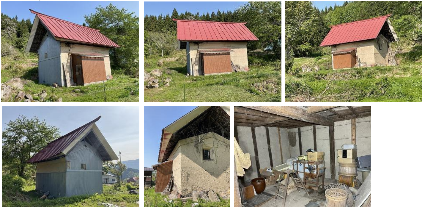
付属建物①（土蔵造倉庫、建築年不詳、1階37.02㎡、2階33.05㎡）
