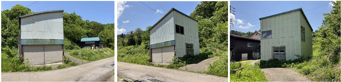
付属建物(車庫・物置) 外観
