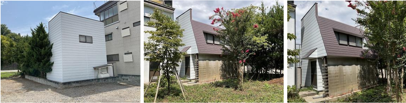
付属建物 （木造亜鉛メッキ鋼板葺2階建物置、平成5年建築、1階14.90㎡、2階14.90㎡、落雪式屋根）
