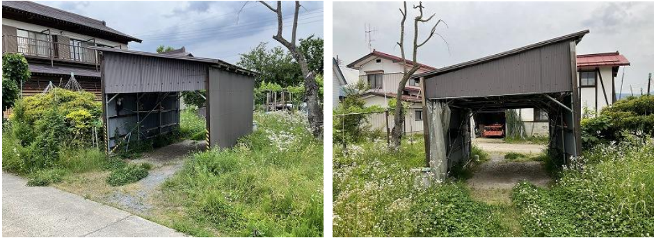
付属建物（単管製車庫、雪下ろし式）
