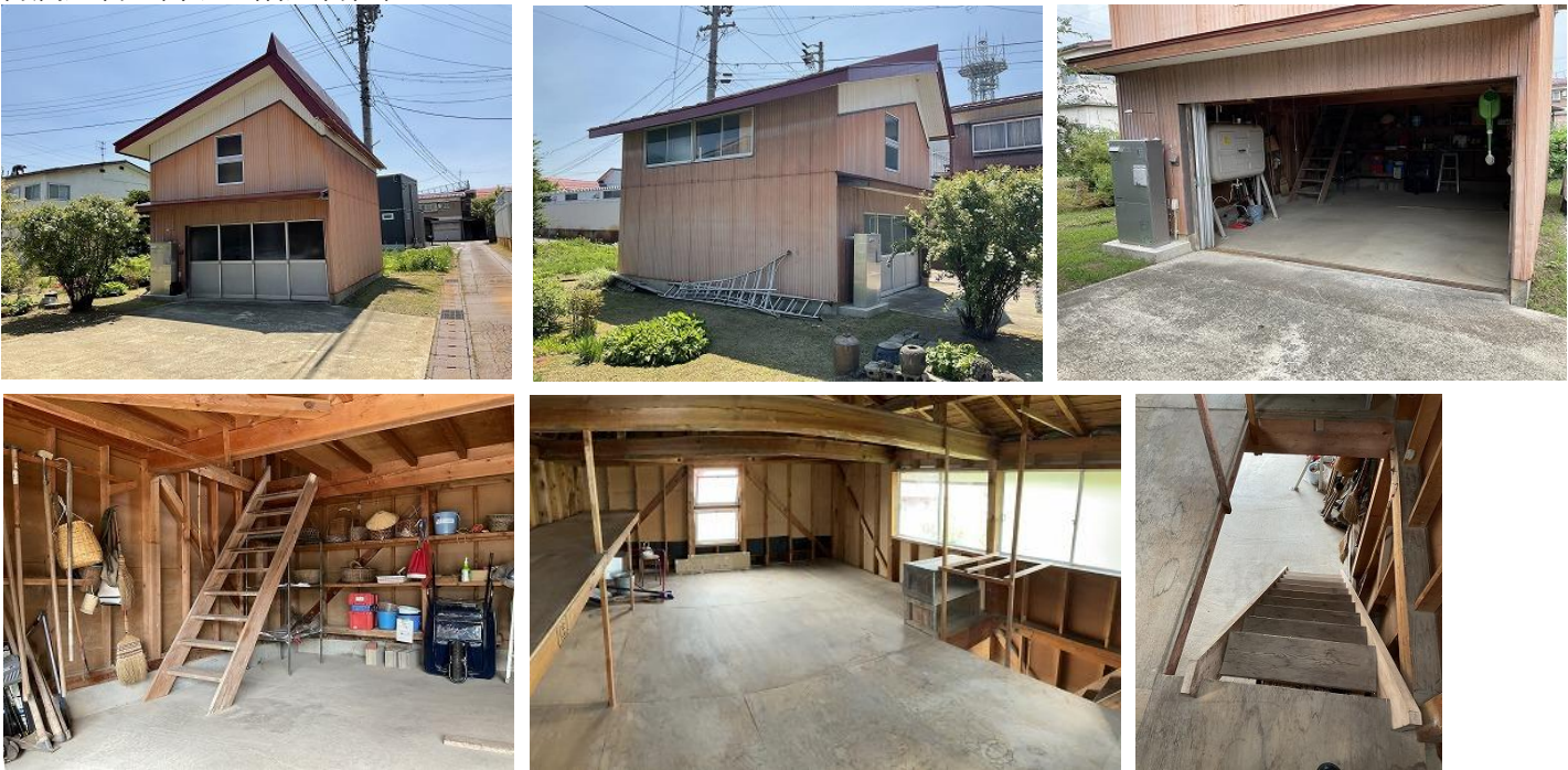
付属建物（木造2階建物置）
