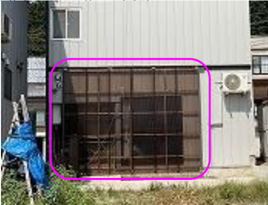
開閉式テラス(住宅東側)
