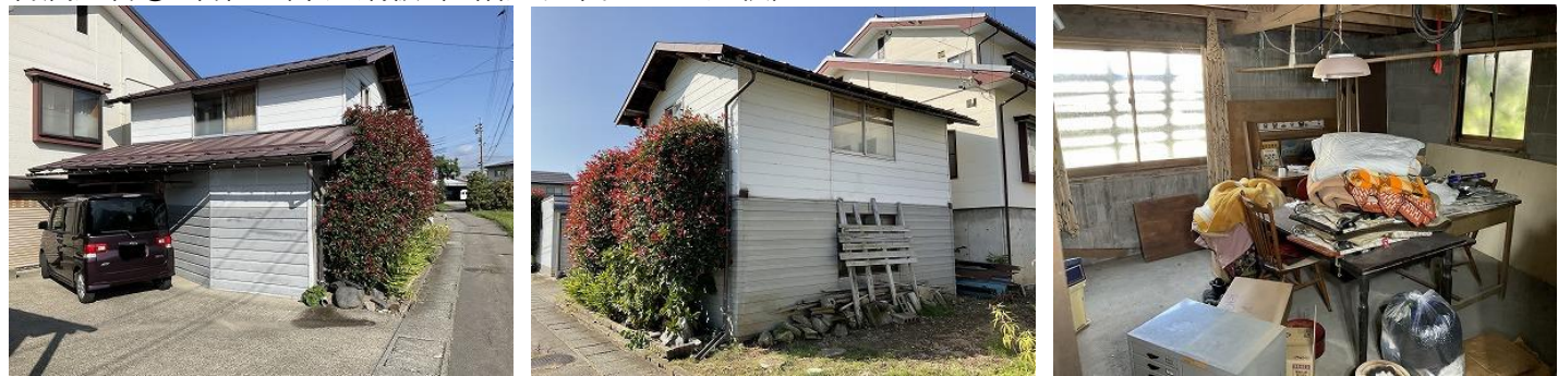
付属建物① 物置（木造鋼板葺2階建、雪下ろし式屋根）
