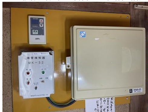
住宅屋根融雪装置 制御盤 (2階6帖間に設置)
