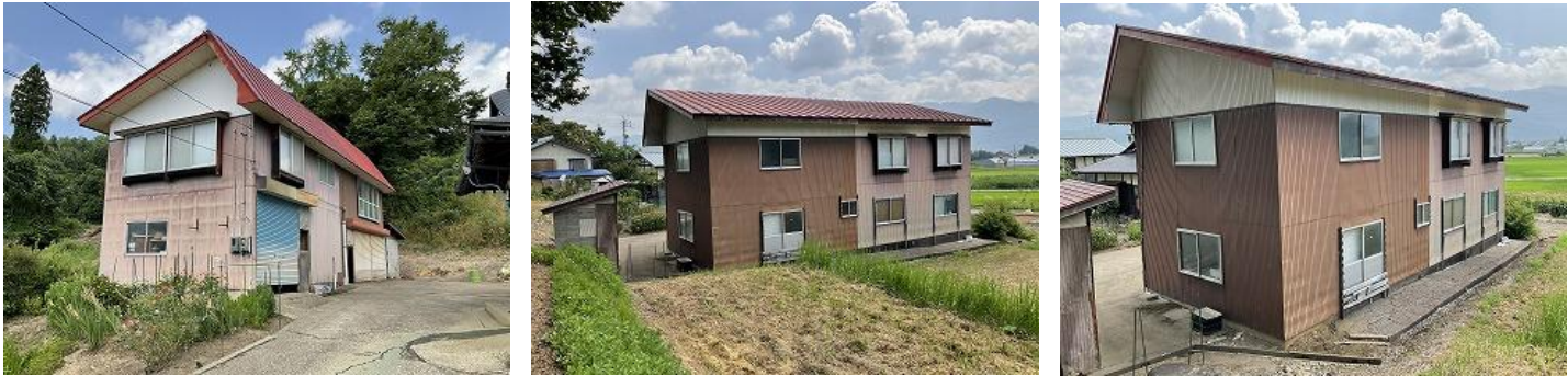
付属建物① 物置・作業場
