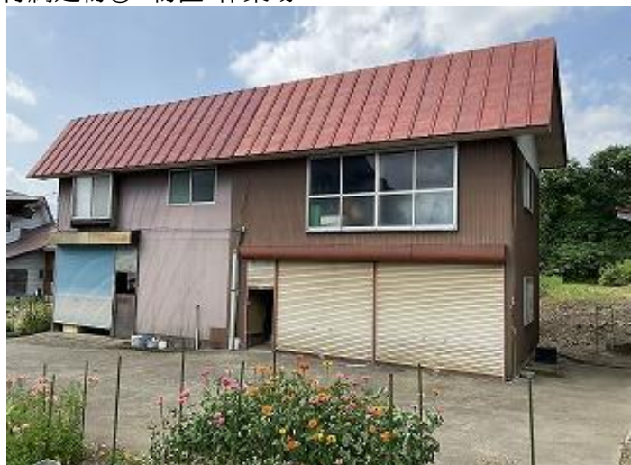
付属建物① 物置・作業場
