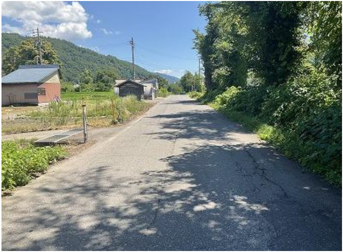
接道（敷地南側、一般県道箕作飯山線、幅員≒7m、除雪路線）
