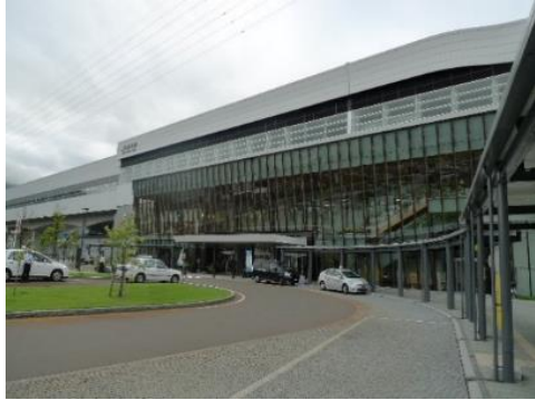
JR飯山駅(北陸新幹線停車駅) 1.4km 車で5分
