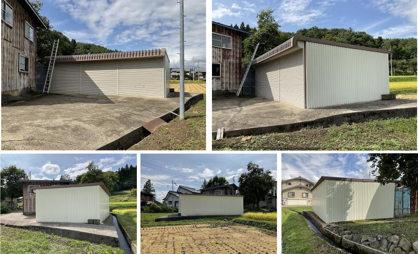
付属建物② 鉄骨造平屋建車庫（H3年建築＝課税簿49.58㎡）雪下ろし式屋根
