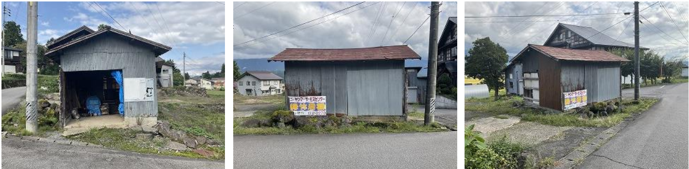
付属建物③（木造平屋建車庫、建築年不詳、自然落雪式屋根）
