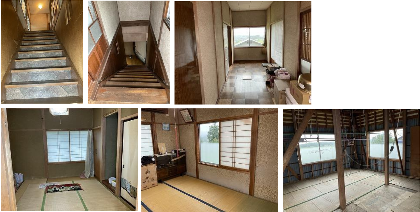
付属建物①（木造2階建物置・居室、自然落雪式屋根）
