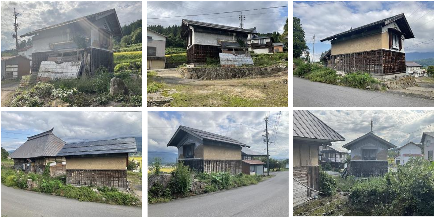
付属建物②（土蔵造亜鉛メッキ鋼板葺2階建、建築年不詳、1階38.01㎡、2階33.05㎡、自然落雪式屋根）
